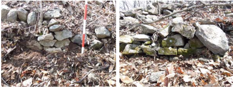
사진3 동북쪽 능선 끝단의 성벽 사진4 서북쪽 능선 끝단의 성벽
