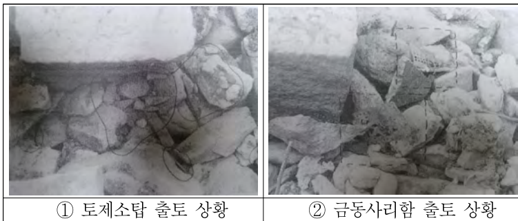
<사진 4> 제천 신록사 삼층석탑 해체수리 공사 장면 (국가기록원 보관본)
