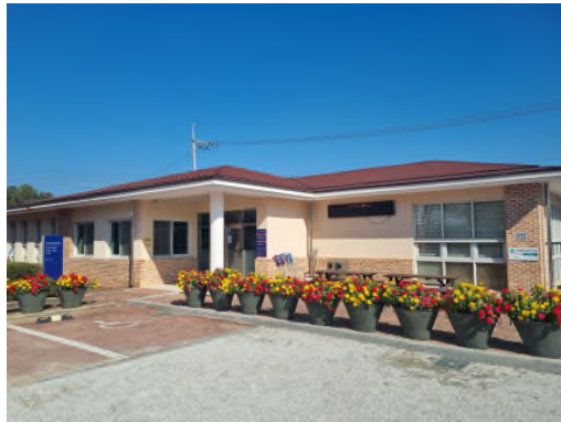
[사진 8] 송국리유적 선사체험관 전경(필자 촬영)
